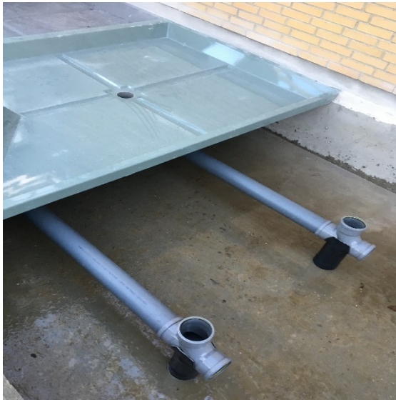
Figur 4. De to afløb inden gyllebakken blev lagt ovenpå og fastgjort.
